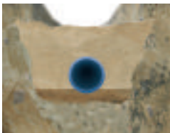
Traditionell läggning i schakt.
